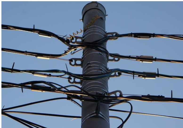
Рисунок 1.6 – Четырехцепная воздушная линия с изолированными проводами
