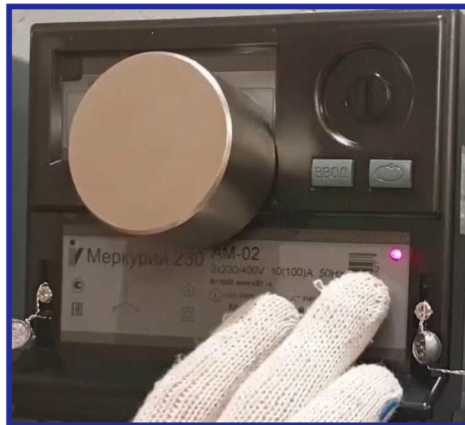
Использование неодимовых магнитов для остановки счетчика
